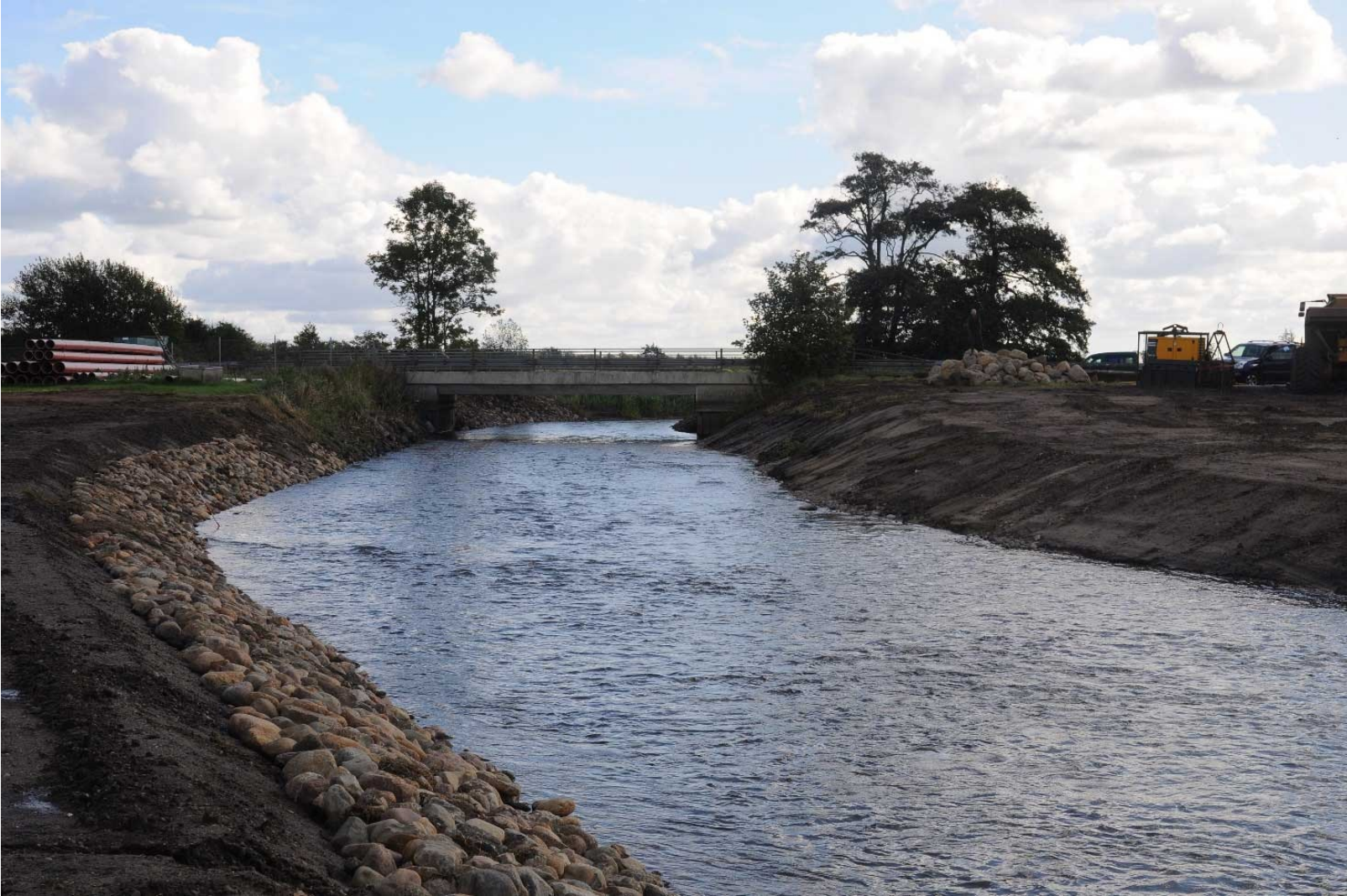
Stryg ved dambrug i Fladså efter stemmeværket er fjernet og ombygget. Foto: Lars M. Svendsen.
