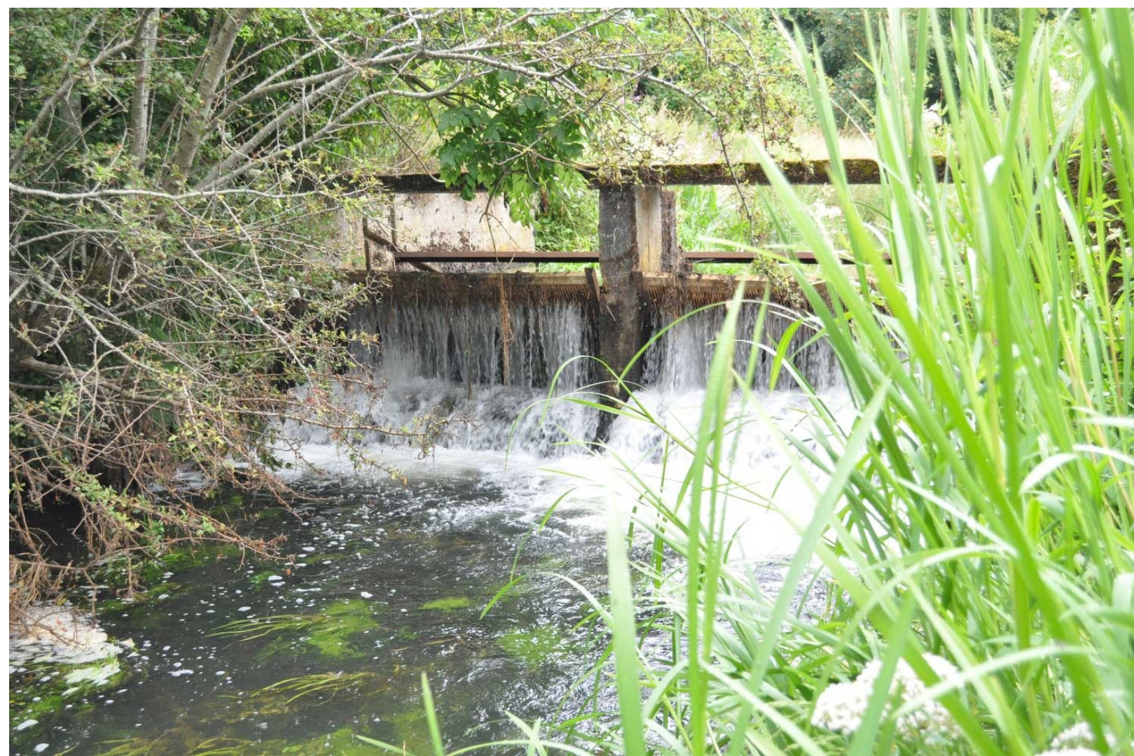
Opstemning ved et mindre ferskvandsdambrug. Foto: Lars M. Svendsen.
