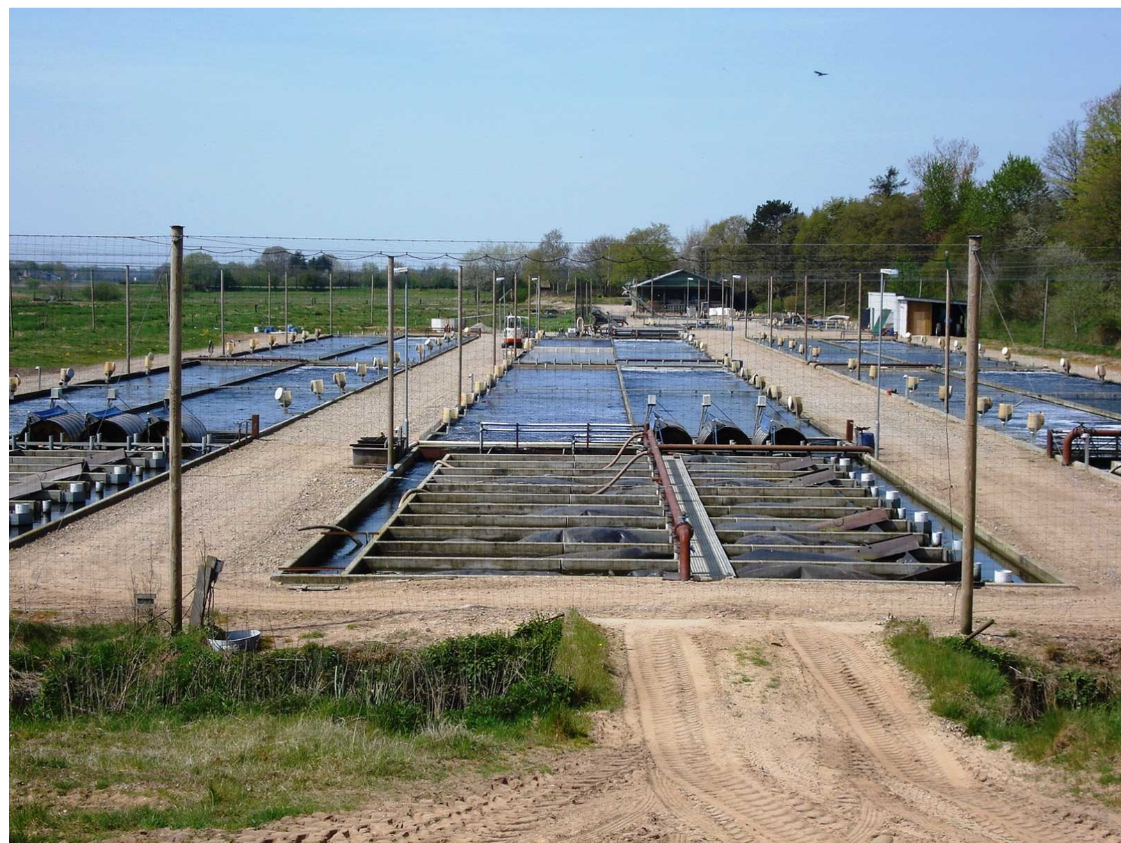
Kongeaens modeldambrug type 3. Produktionsenhederne omfatter tre sektioner, der hver består af to betonraceways med mikrosigter (maskestørrelse 74 \mu m) foran biofiltersektionerne (forgrunden). I baggrunden er plantelagunerne bestående af de tidligere jorddamme og indløbs- og udløbskanaler. Foto: Lars M. Svendsen.
