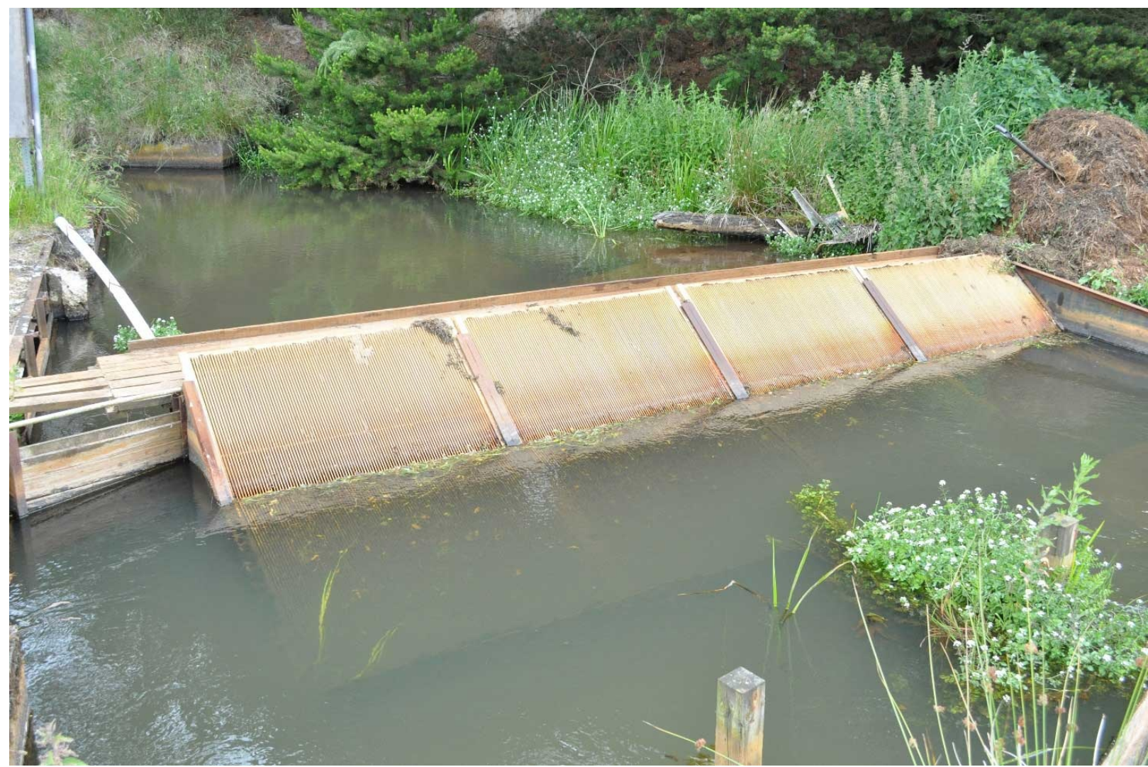
Faararist ved Løjstrup Dambrug. Risten forhindrer små fisk i at svømme ind på dambruget. Foto: Lars M. Svendsen.
