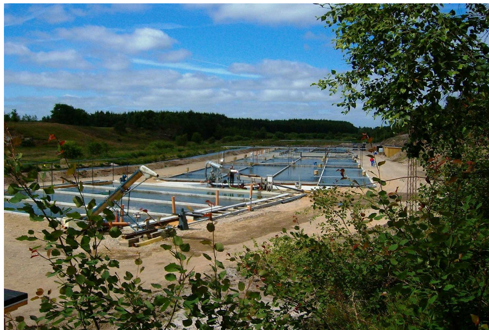
Ejstrupholm modeldambrug type 3. Produktionsanlægget omfatter 2 sektioner hver bestående af to beton raceways (rektangulære betonkar). I forgrunden tre betondamme til levering af fisk. I baggrunden til venstre plantelagunerne bestående af de tidligere jorddamme, der nu er begroet med planter. Foto: Lars M. Svendsen.
