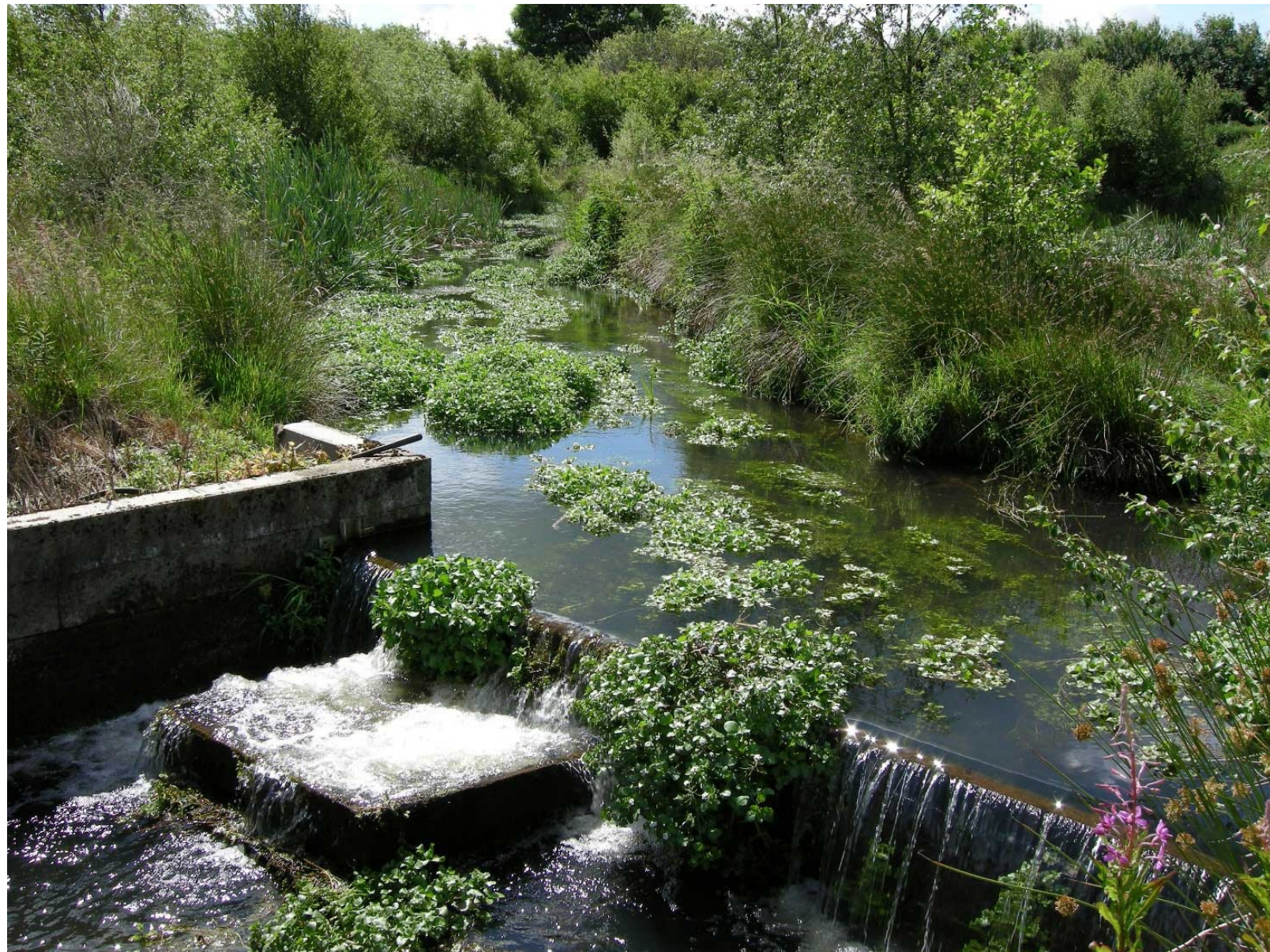
Iltning af afløbsvand fra dambrug, inden det ledes i åen. Foto: Lars M. Svendsen.
