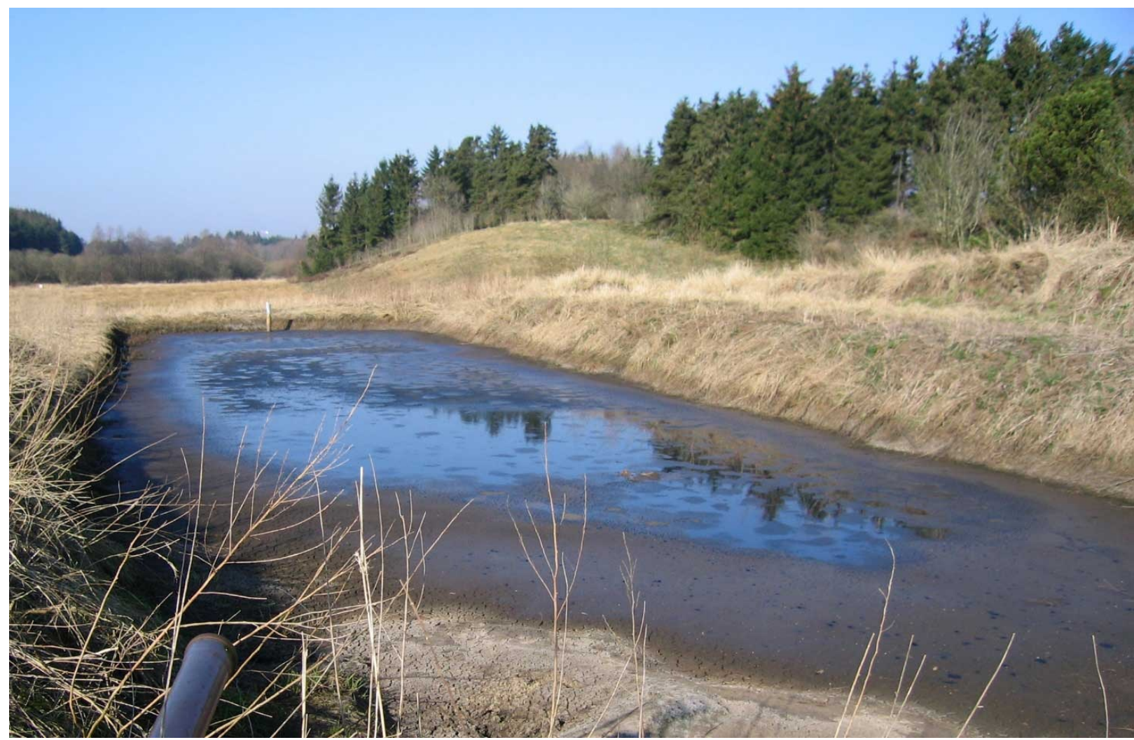
Fra slamkeglerne transporteres slammet til slambassiner/tanke, hvor det bundfældes. Billedet er fra Ejstrupholm modeldambrug. Foto: Alfred Jokumsen.
