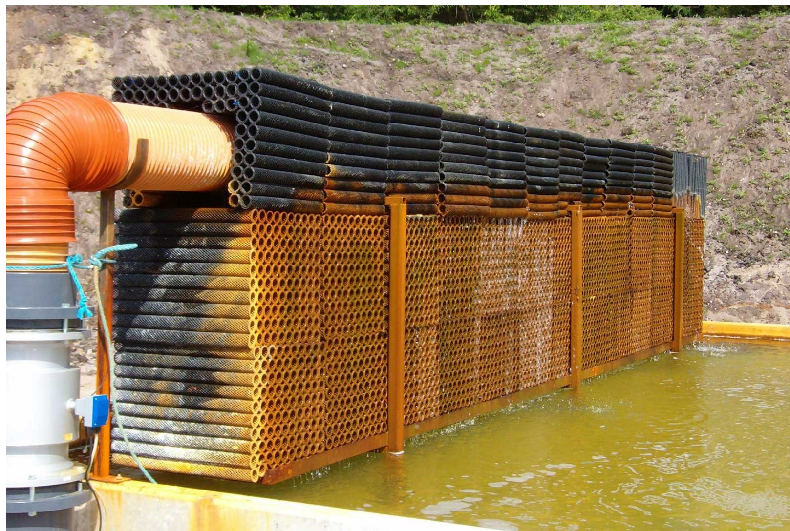
Bruges grundvand kan der være behov for at fjerne jern (okker) eller tilsætte kalk for at hæve pH. Foto: Lars M. Svendsen.
