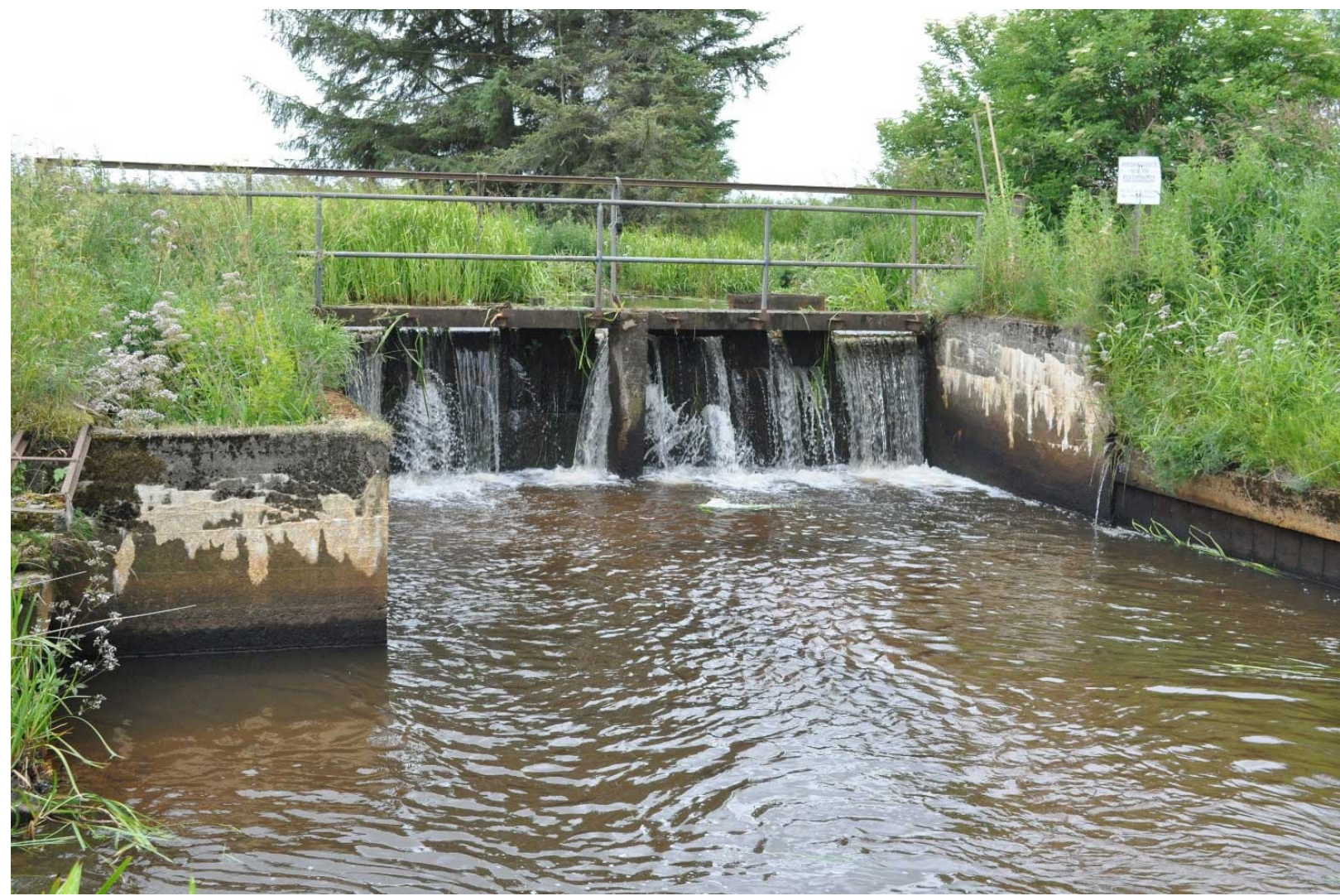
Stemmeværk, der opstemmer vandet i den øvre Karup Å. Foto: Lars M. Svendsen.
