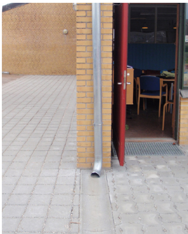
LAR-anlæg med permeable belægninger.
